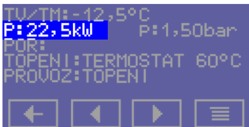
P: OKAMŽITÝ VÝKON KOTLE
