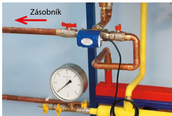
Připojení zásobníku TV ke kotli
