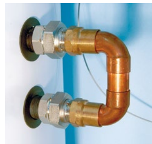
Propoj topných vložek zásobníku TV
