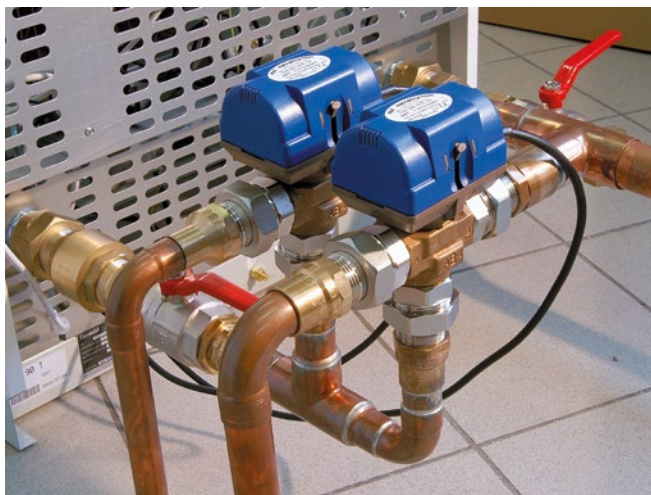
Alternativa 1 - zapojení dvou 1" trojcestných ventilů
