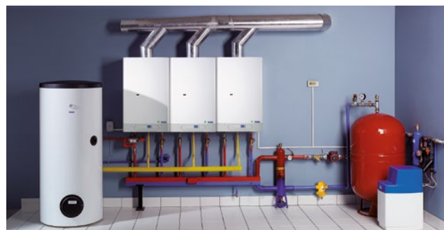
Kotelna s třemi kotli THERM DUO 50.A
